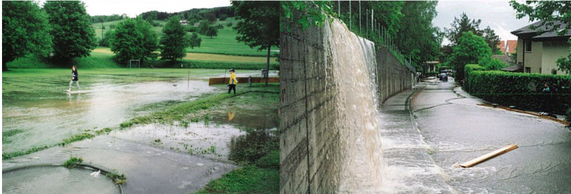
Mai 1999: überflutetes Gelände beim Mehrzweckgebäude. Mai 1999: Wasser rauscht auf die Kochsmattstrasse. ZVG
